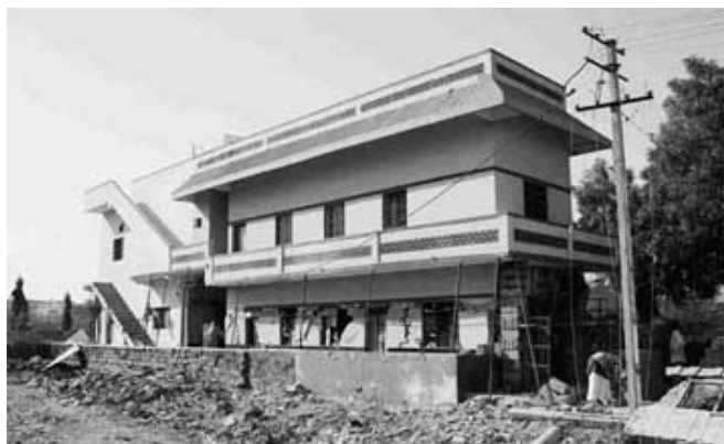
写真1 微動観測を行った建物（A：奥，B：手前）
