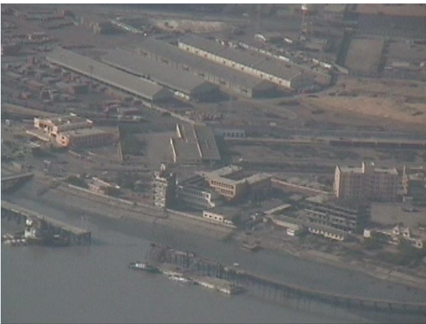
図4(d) Kandla Port の空撮画像の例 6) ( 上：図2(d) 右上の推定被害地域の様子 ) ( 下：図2(d) 右下の推定被害地域の様子 )
