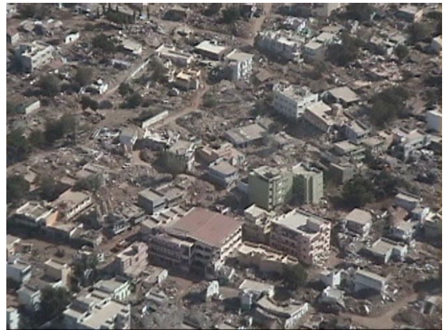
図4(a) Bhachauの空撮画像の例 6) (図2(a)中央やや左の推定被害地域の様子：多くの倒壊建物を確認できる)
