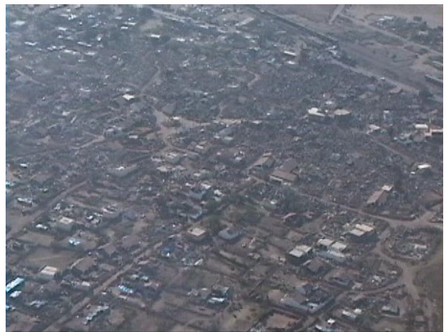
図4(f) Ratnal の空撮画像の例 6) ( 壊滅的な被害を受けていることを確認できる )
