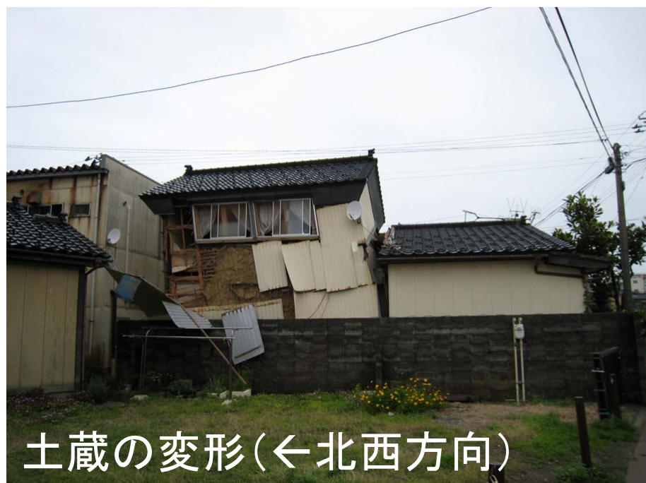
1階が変形した住宅(北西方向)
