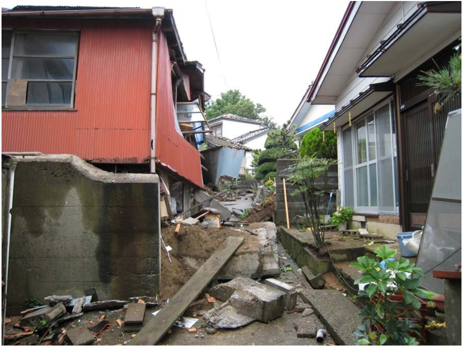
(左上)擁壁・ブロック塀の転倒と住宅・倉庫への被害
