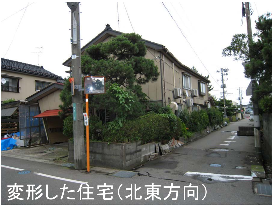
1階が変形した住宅(北西方向)
