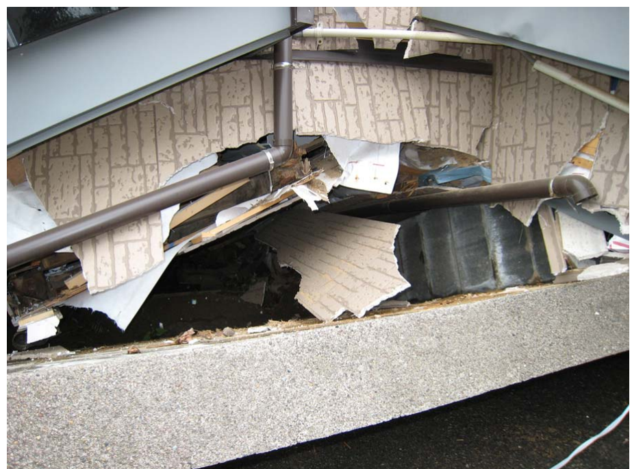
築年は比較的古い(外壁をリフォームした)とのこと
